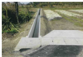
【農業用水路の改修】
