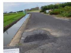
【農道陥没補修】
