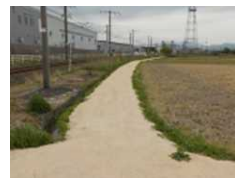
【真砂土による農道補修】
