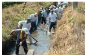
【農業用水路の浚渫】
