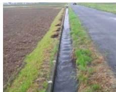
【農業用水路の目地補修】
