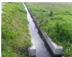
【農業用水路の改修】
