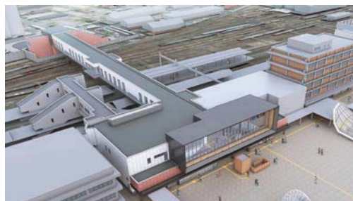
▲米子駅北口から見た自由通路
