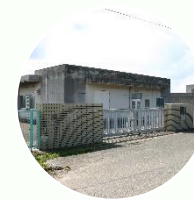
日吉津水源地
