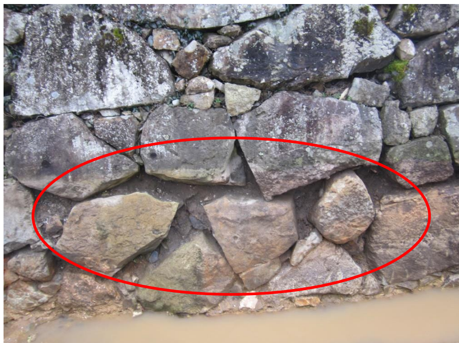
写真4 間詰石(まづめいし)が欠落した部分
