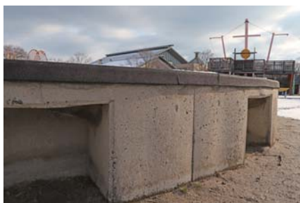
砂場は高さがあり、車椅子でも利用することができる（ユニバーサル遊具）
