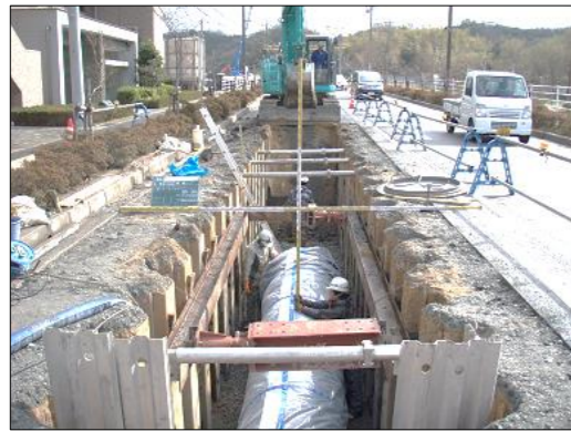
(配水管取替工事の様子)
