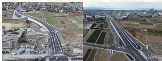
▲市道安倍三柳線(1工区)
