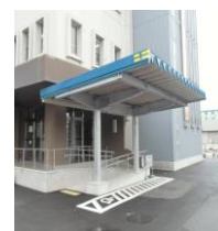
車いす使用者用駐車場、スロープ、手すり
