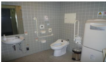
車いす使用者用トイレ
