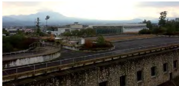
皆生浄化センター（現状）
