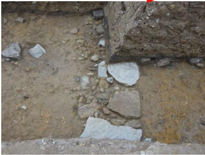
駐車場部分の建物基礎
