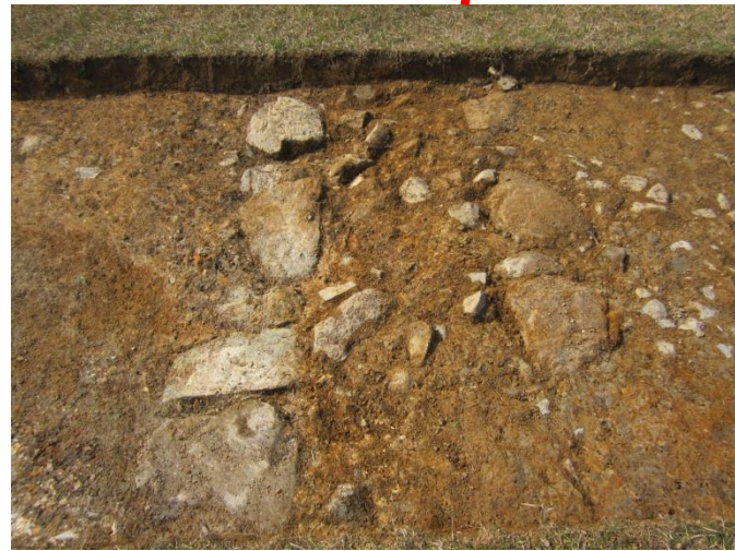
旧野球場部分の建物基礎
