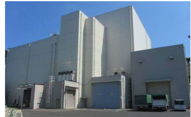
サイトバンカ建物外観
