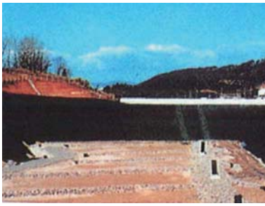
一般廃棄物最終処分場
