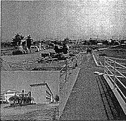
(加茂中・正門前付近の工事現場)
