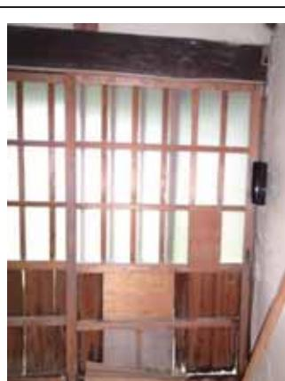
建具の破損状況（南室出入口の引き戸）
