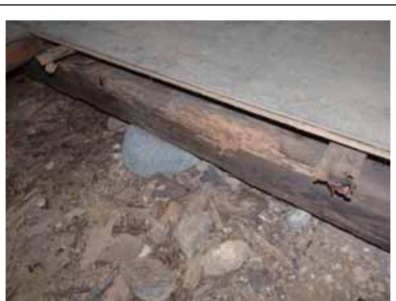
転ばし根太（大引）の腐朽状況
