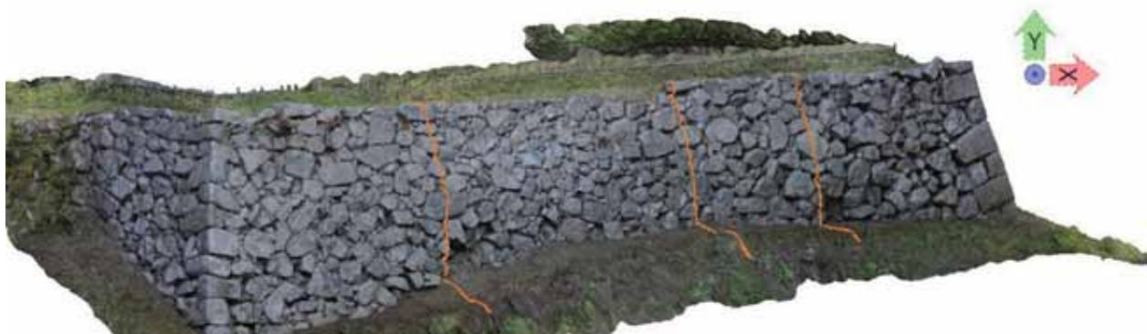
【3次元写真測量によるオルソ画像と断面図】（例：豊岡市 市史跡出石城跡）
