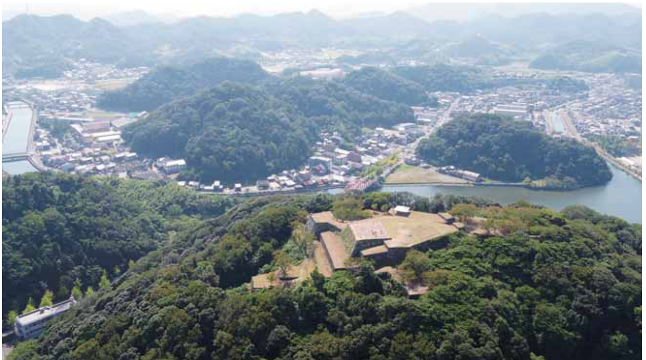
北西上空から見た米子城跡本丸
