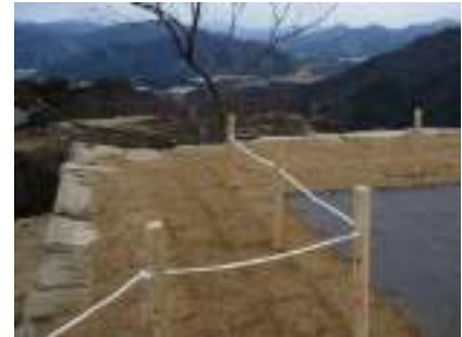
覆土と張芝による遺構面の保護 (史跡竹田城跡)
