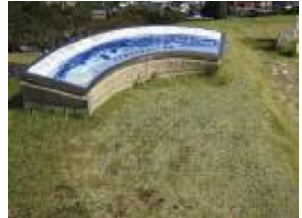
芝生保護材の設置(特別史跡肥前名護屋跡)
