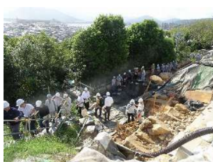
修理工事の現地見学会（唐津城跡）
