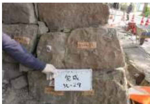
修理後（樹脂材の充填＋擬岩処理）
