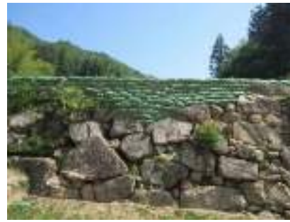
植生土嚢の充填 (史跡竹田城跡)
