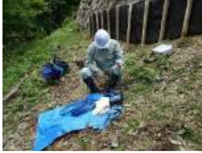
石垣前面斜面の観測 (市史跡出石城跡) ・ 孔内傾斜と地下水位観測
