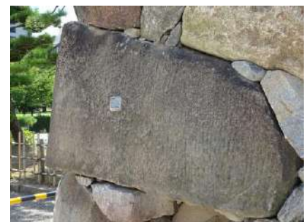
3次元座標計測用標点の設置 (史跡高松城跡)
