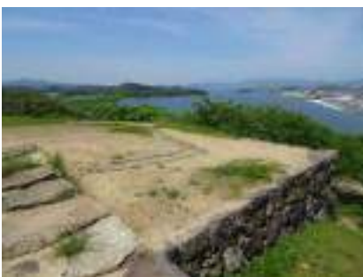
遺構保護土の流出（天守）
