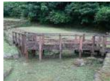
遺構保護のための木製デッキ (史跡新宮城跡 和歌山県)
