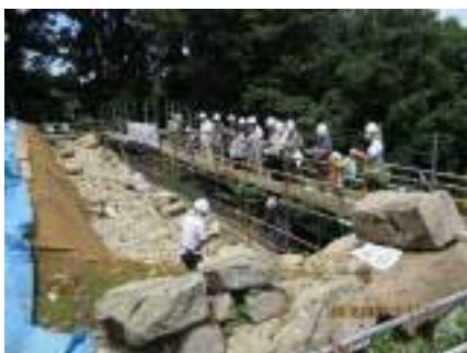
修理工事の現地見学会 （市史跡出石城跡）
