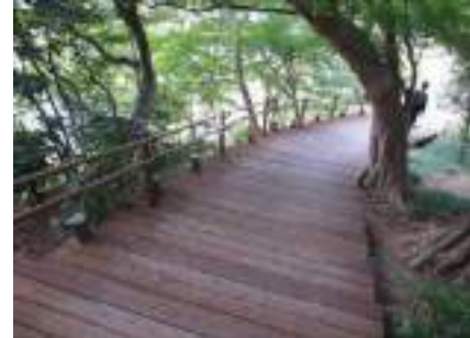
遺構保護のための木製階段 (史跡金沢城 石川県)
