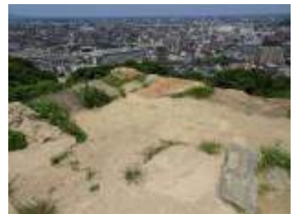
土系硬化舗装の破損部（天守） ・欠損部の表土が固結し雨水排水に支障をきたしている。
