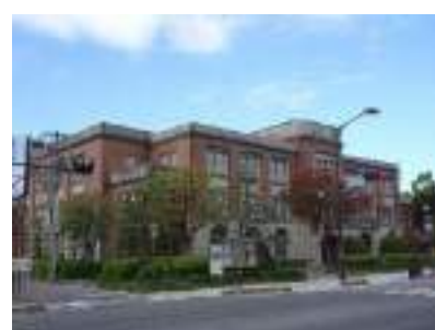
米子市役所旧館(市指定有形文化財)
