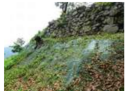
植生シートによる基盤の保護 (史跡有子山城)
