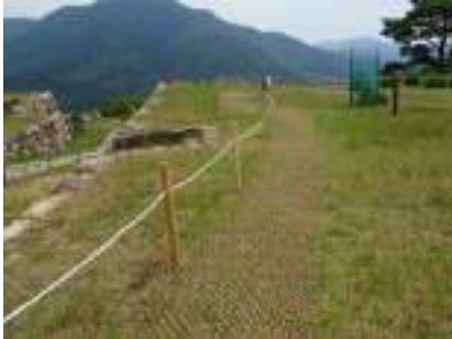
芝生保護材の設置(史跡竹田城跡)
