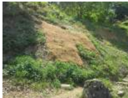
ヤシ繊維ネットに斜面保護 (特別史跡一乗谷朝倉氏遺跡) ・平成 16 年 7 月の福井豪雨により被災しその復旧工事。
