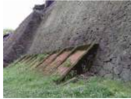
コンクリート構造物による石垣 前面の補強（特別史跡熊本城跡）
