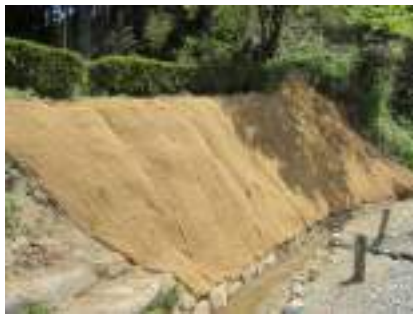
ヤシ繊維ネットに斜面保護 (特別史跡一乗谷朝倉氏遺跡) ・平成 16 年 7 月の福井豪雨により被災しその復旧工事。
