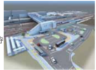
米子駅南駅前広場
