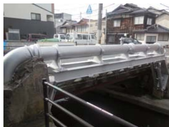
鞆町橋水管橋
