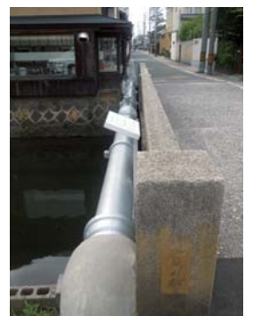
加茂川橋水管橋
