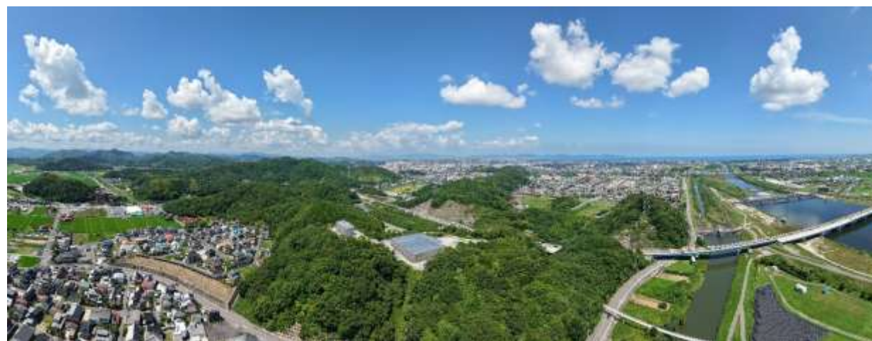
ドローンで撮影した中央、南部配水池
