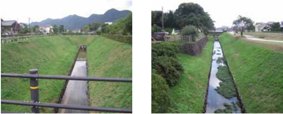
史跡菟城跡 外堀復元状況
