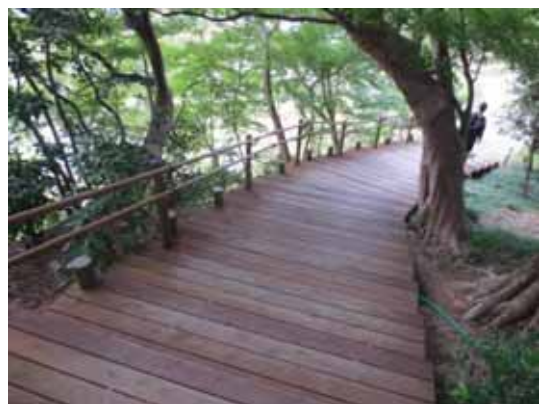
遺構保護と環境に配慮した木製階段 (史跡金沢城跡)
