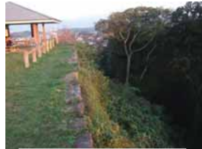
天守東屋南側の転落防止柵
