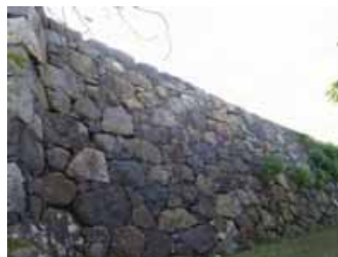
本丸石垣修理箇所
