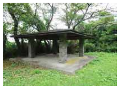
コンクリート製東屋
