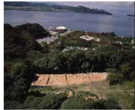
内膳丸石垣修理状況(平成13年)
