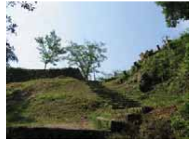
樹木伐採箇所
