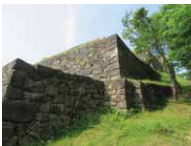
本丸石垣修理箇所
