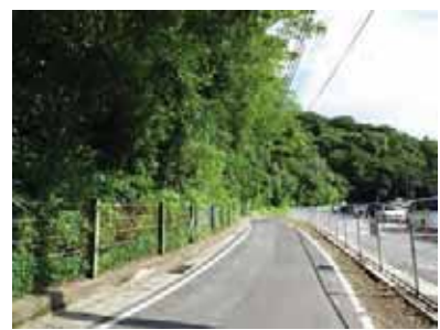
道路沿いの落石防止柵
