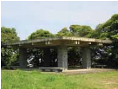
コンクリート製東屋とベンチ
