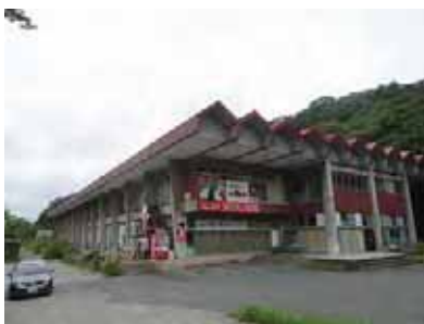
スポーツ施設
