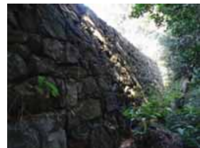
内膳丸石垣修理箇所
