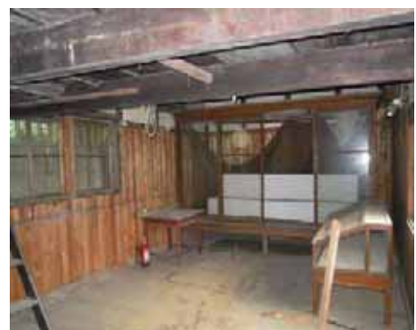
旧小原家長屋門内部の現況
