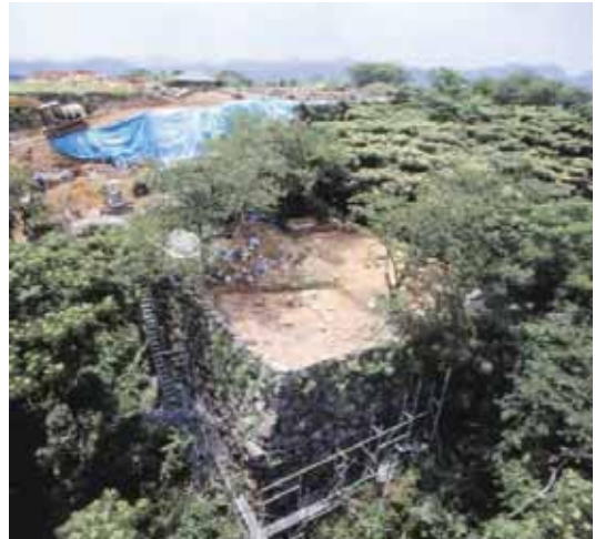
天守、遠見櫓石垣修理状況(平成13年)
