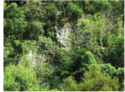
岩盤の落石防止ネット
