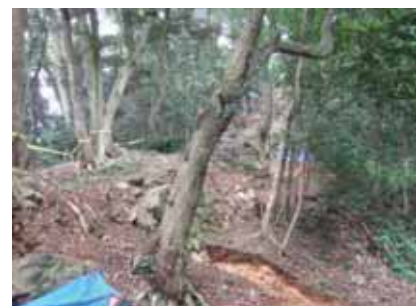
登り石垣に繁茂する樹木
