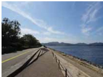
湊山公園「護岸遊歩道」
