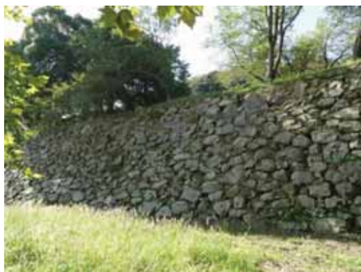
二の丸石垣 打込みハギ、布崩し積み
