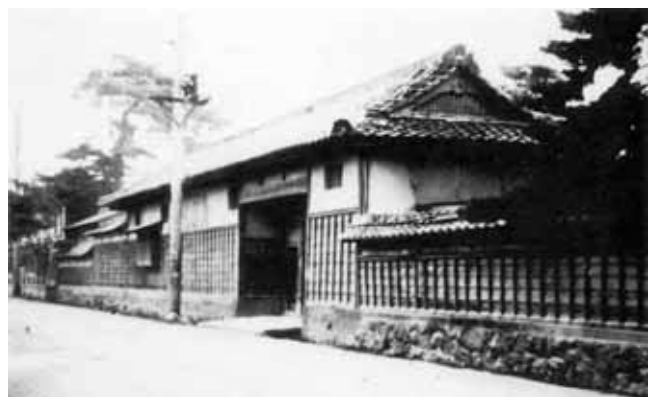
西町小原家長屋門(昭和20年代撮影) (『米子市史第13巻』資料編写真より)
