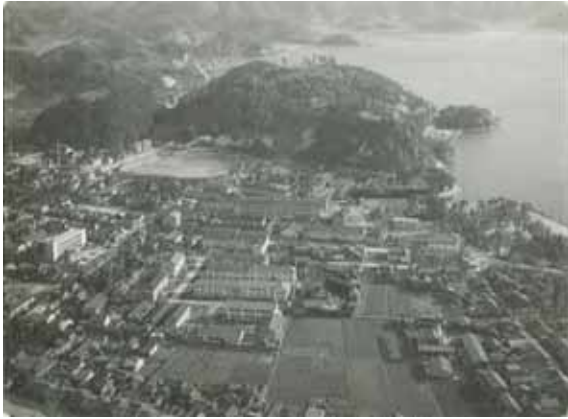
国道9号開削前の米子城跡 (南を望む・昭和31年)
