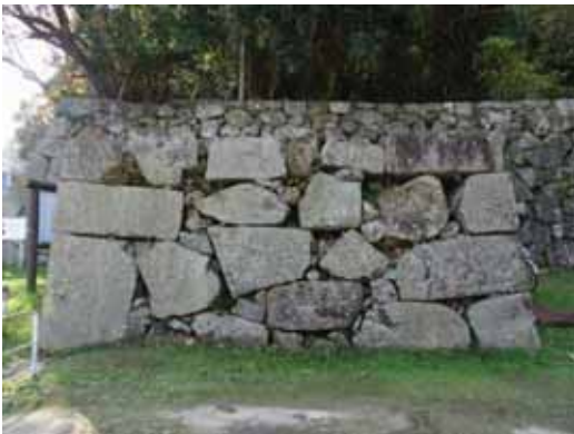
二の丸石垣 (桁形) 打込みハギ、布崩し積み 隅角部:算木積み
