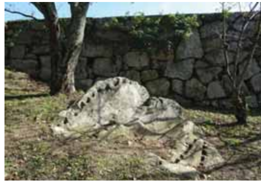
矢穴痕が残る岩盤露頭
