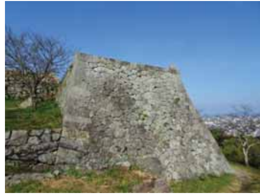
四重櫓台石垣 (幕末に積み直し) 切込みハギ、谷落し積み 隅角部:算木積み
