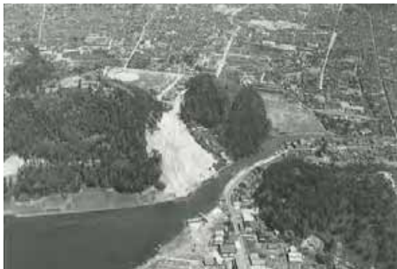
国道9号工事中の深浦(昭和33年頃)
