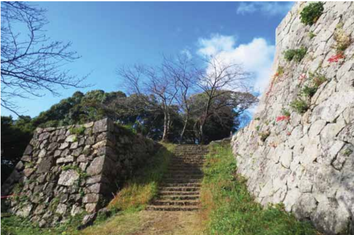
本丸冠木御門脇石垣（打込みハギ）と四重櫓台石垣（切込みハギ）
