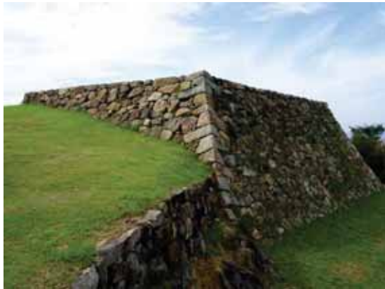
天守台石垣 ・打込みハギ、布崩し積み、隅角部：算木積み
