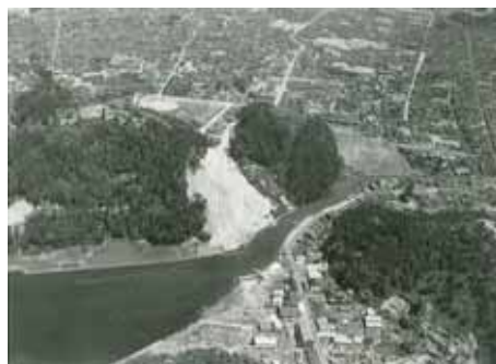
9 号線工事中の深浦(昭和 31 年)
