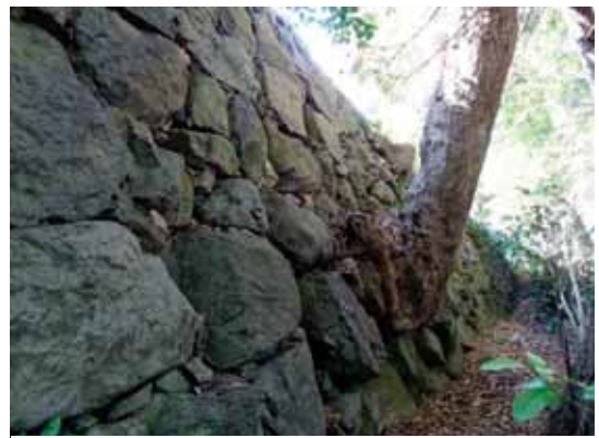
内膳丸石垣 打込みハギ、布崩し積み・石垣面に樹木
