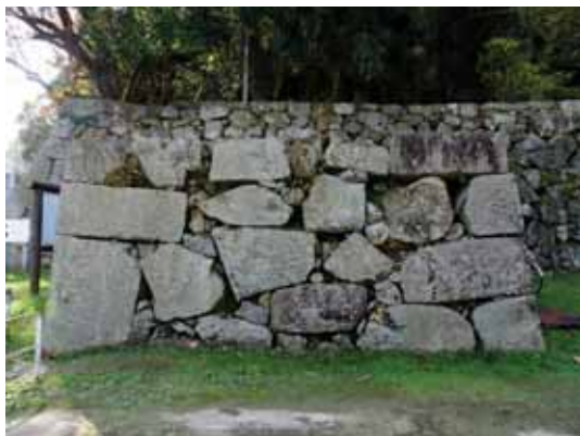
二の丸石垣(枡形) ・打込みハギ 布崩し積み 隅角部：算木積み
