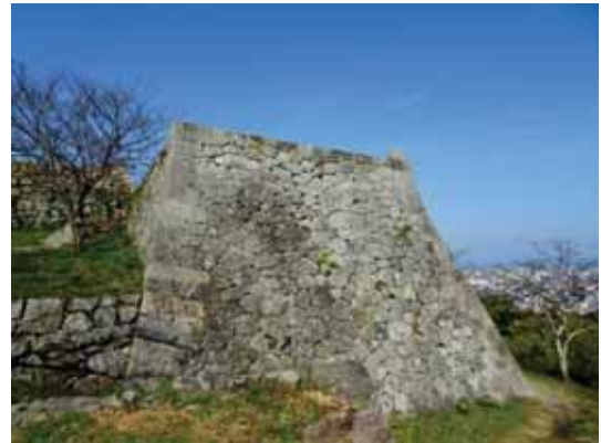
四重櫓台石垣（幕末に積み直し） ・切込みハギ、谷落し積み、隅角部：算木積み
