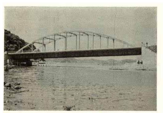
深 浦 大 橋 深浦大橋
