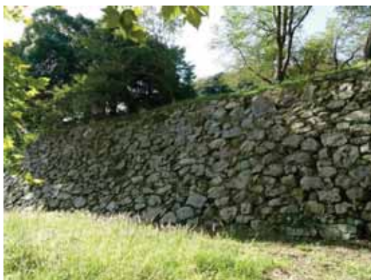
二の丸石垣 打込みハギ、布崩し積み
