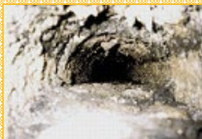
油が付着した下水道管の内部
