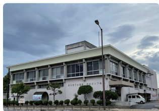
下水道中央ポンプ場
