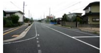
皆生温泉環状線改良
