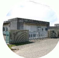
日吉津水源地
