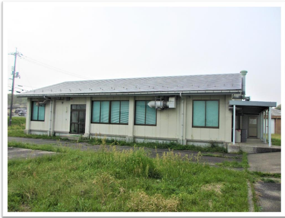
戸上水源地 水質検査室
