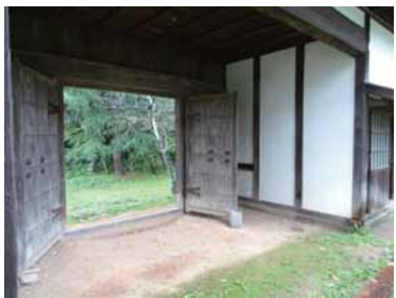
古い柱が残る大扉付近
