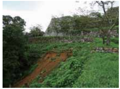
堅堀上部(番所跡付近)の切岸
