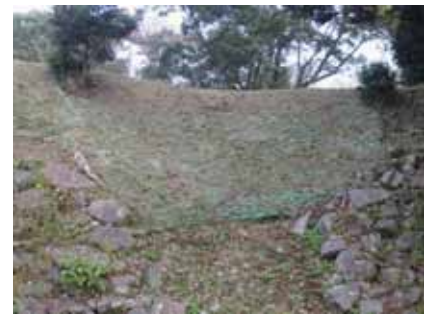
植生土嚢による斜面保護 (特別史跡肥前名護屋城跡)
