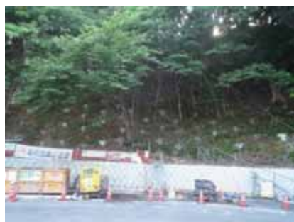
ノンフレーム工法による斜面補強 (史跡米子城跡 平成22・23年)
