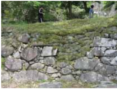
植生土嚢の充填 (特別史跡安土城跡)
