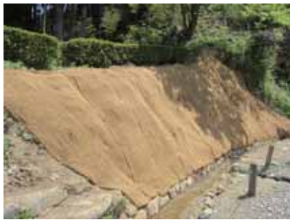
ヤシ繊維ネットによる斜面保護 (特別史跡一乗谷倉倉氏遺跡) ・平成 16 年 7 月の福井豪雨により被災しその復旧工事
