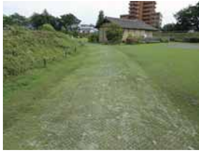
芝生保護材の設置(史跡湯築城跡)
