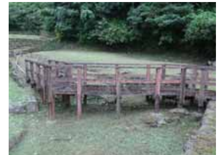
遺構保護のための木製デッキ （史跡新宮城跡）
