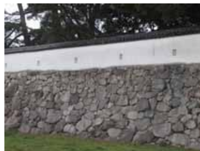
土塀の復元整備(史跡萩城跡)
