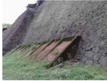
コンクリート構造物による石垣 前面の補強（特別史跡熊本城跡）
