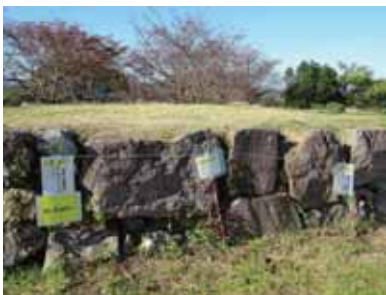
石垣保護のために緊急的に設置した立入制限の表示
