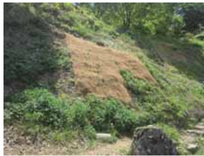
ヤシ繊維ネットによる斜面保護 (特別史跡一乗谷倉倉氏遺跡) ・平成 16 年 7 月の福井豪雨により被災しその復旧工事
