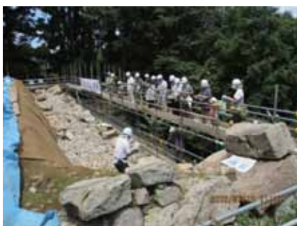
修理工事の現地見学会（市史跡出石城跡）
