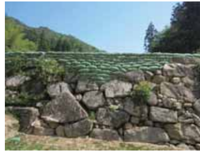
植生土嚢の充填（史跡竹田城跡）
