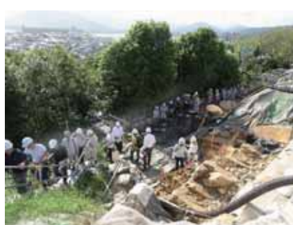
修理工事の現地見学会（唐津城跡）
