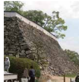
石垣の天端に整備された塀 (史跡岡山城跡)
