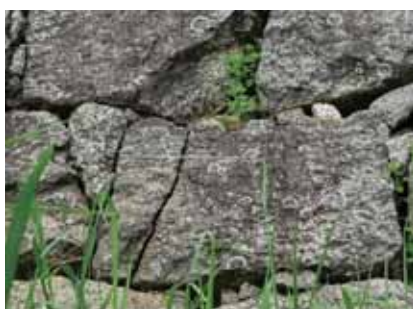
石材の割れ部にガラス棒を設置 (史跡丸亀城跡)
