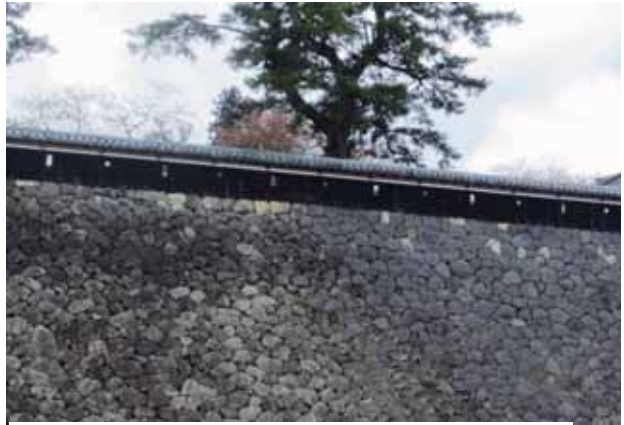
土塀の復元整備（史跡松江城）
