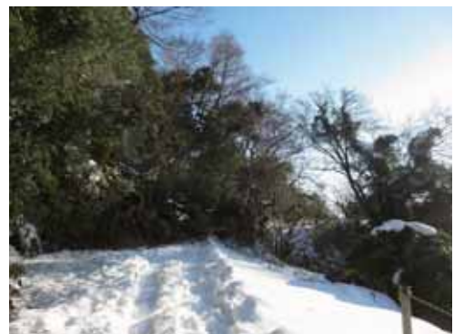
大雪による法面崩落(平成29年2月)
