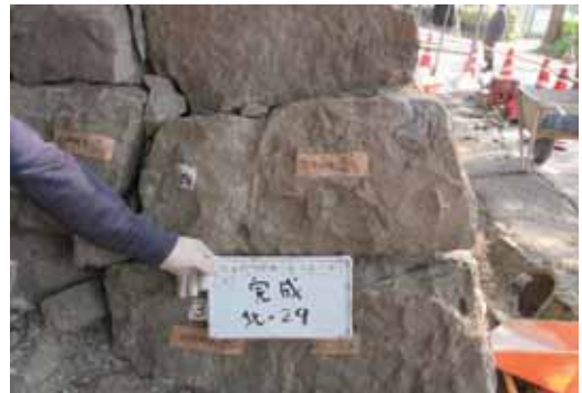
修理後（樹脂材の充填＋擬岩処理）
