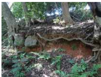
斜面に残る石垣の底部が現れている
