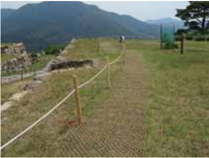
芝生保護材の設置(史跡竹田城跡)
