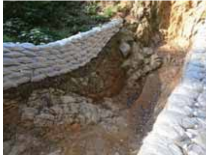
堅堀の岩盤削掘部
