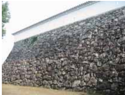
石垣の天端に整備された塀 (市史跡福知山城跡)
