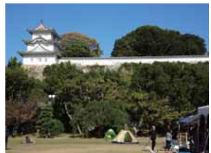
土塀の復元整備(史跡明石城跡)
