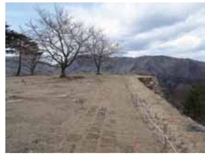
覆土と張芝による遺構保護 (史跡竹田城跡)
