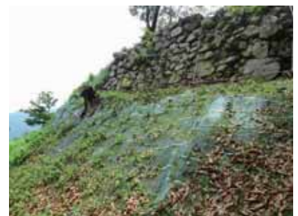
植生シートによる基盤の保護 (史跡有子山城跡)
