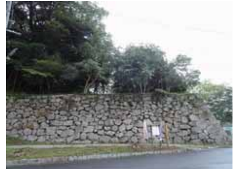
石垣面の樹木伐採後の状況 (二の丸石垣)
