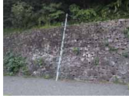
石垣上部斜面の変位観測 (史跡金沢城跡)
