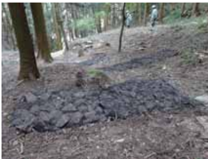
雨水排水の流速低下と分散を目的とした袋型フトンカゴ 平成27年度(史跡津和野城跡：平成25年の豪雨災害復旧工事)
