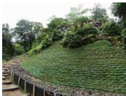
同左：植生土嚢とネット状フトン カゴによる基盤の保護
