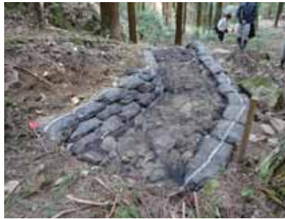
雨水排水の流速低下と分散を目的とした袋型フトンカゴ 平成27年度(史跡津和野城跡：平成25年の豪雨災害復旧工事)
