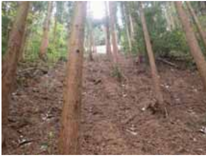
ノンフレーム工法による斜面補強 (史跡津和野城跡 平成 28 年)
