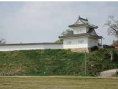
隅櫓(木造)と塀の整備 (市史跡岡崎城跡)
