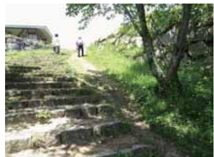
石段際の土壌の流出（鉄門付近）
