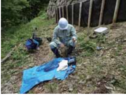
石垣前面斜面の観測 (市史跡出石城跡)
