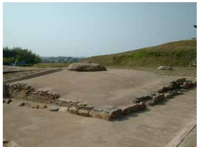
中塔基壇の出土状況（左）と整備状況（右） 整備では心礎を元の位置に復元
