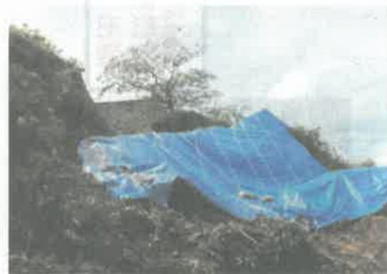
法面シート保護
