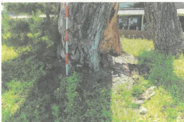
写真13 東側の根元、空洞がみられる。
