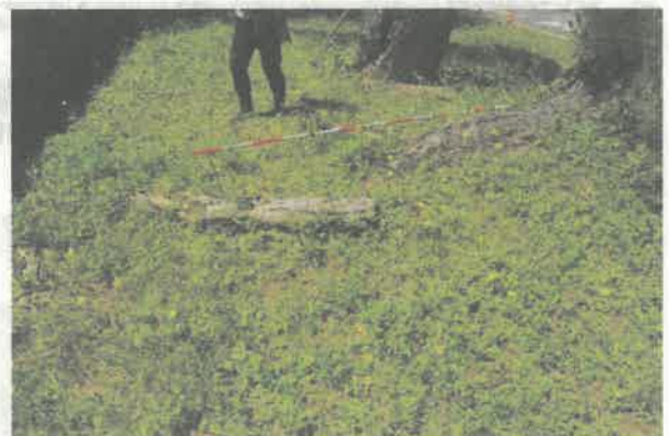
写真14 西側の浮き根
