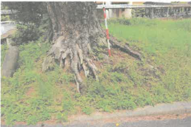
写真27 東側からみた根元の腐朽
