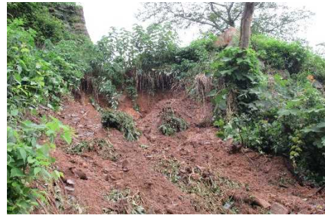
崩落箇所(近景)
