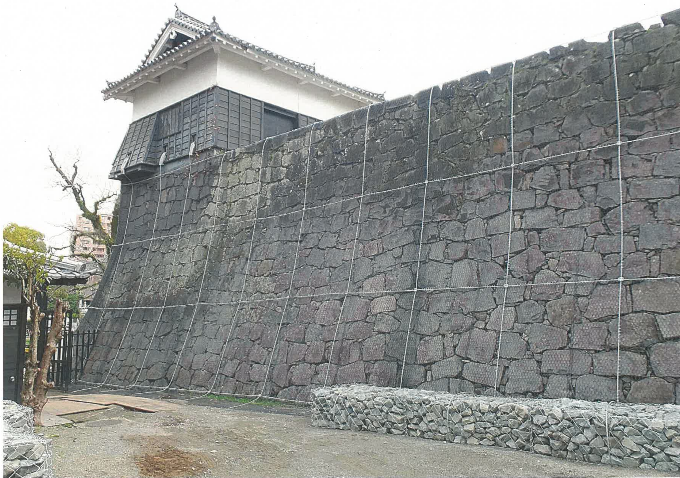
石垣保護ネット施工事例（熊本県・熊本城跡）
