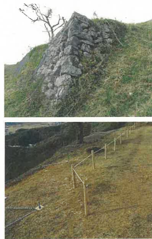
黒井城跡：石垣背面地盤へのアンカー設置 アンカー手前にロープ柵を設置 (兵庫県・丹波市)
