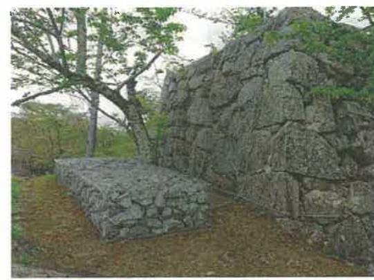
松坂城跡：アンカーを打ち込まずフトンカゴで固定 (三重県・松阪市)
