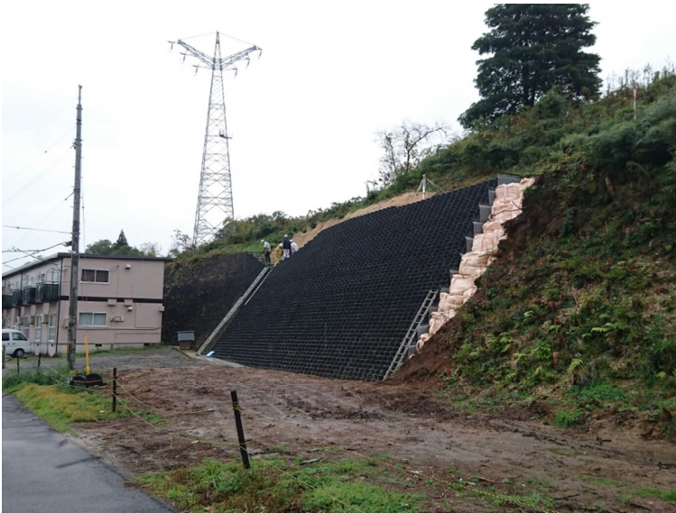
史跡青木遺跡法面崩落防止工事完成状況
