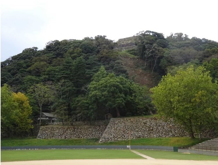
史跡米子城跡危険木伐採状況
