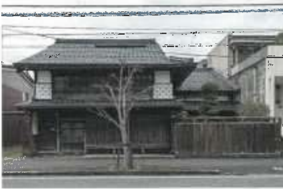
判屋船越家住宅主屋外観①
