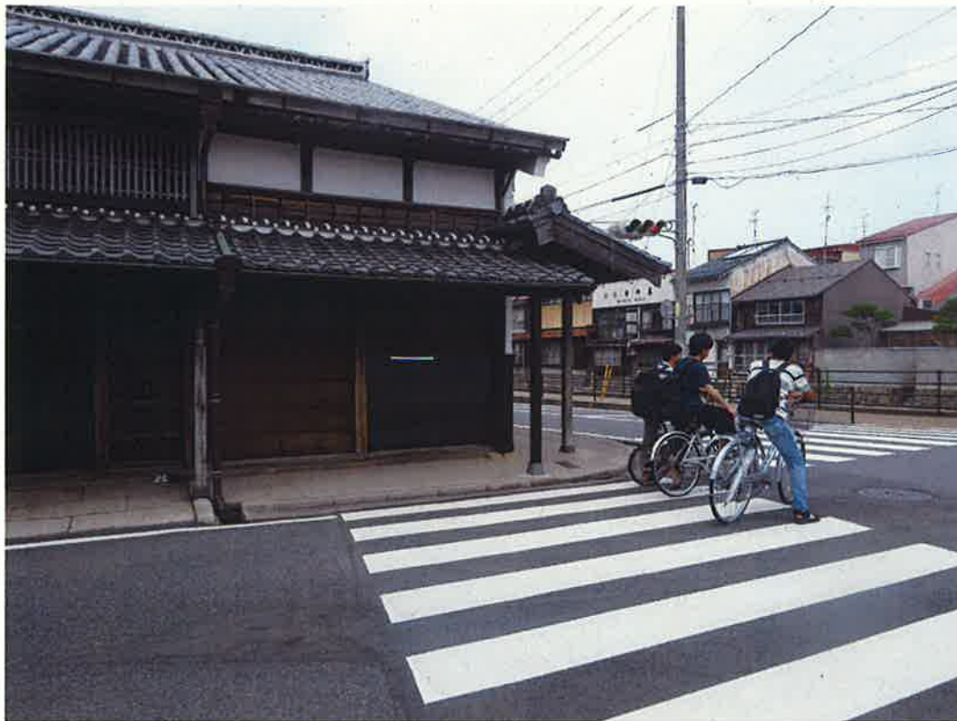
写真6 後藤家既存箇所修繕完了写真
