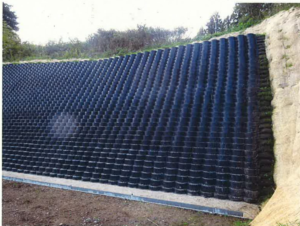
写真2 青木遺跡5号地法面崩壊対策工事完了の様子
