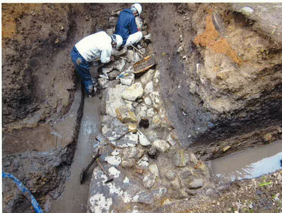
図2 石列の検出状況(北西より)
