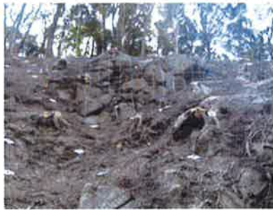
同左：補強材(ロックボルト)と、 高強度ネット斜面補強
