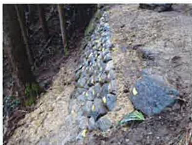
同上：石垣積み替え後の状況
