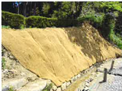
ヤシ繊維ネットに斜面保護(特別史跡 一乗谷朝倉氏遺跡) ・平成 16 年 7 月の福井豪雨により被災しその復旧工事。
