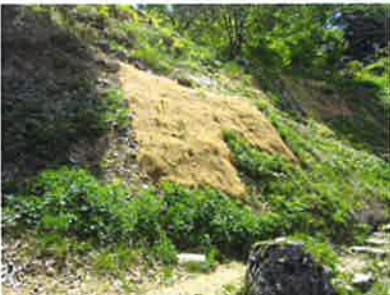
ヤシ繊維ネットに斜面保護(特別史跡 一乗谷朝倉氏遺跡) ・平成 16 年 7 月の福井豪雨により被災しその復旧工事。
