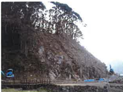
ノンフレーム工法による斜面補強 (史跡新宮城跡 平成 23 年)
