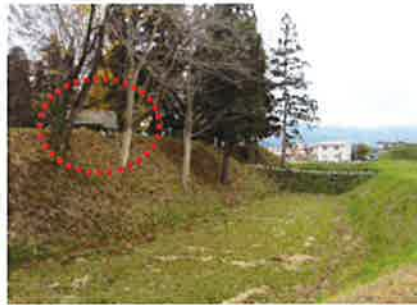
同左の見学デッキ（堀跡などを望む）
