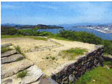
遺構保護土の流出 ・来訪者が集中する石垣天端際の構保護土が流出し、石垣の保存に支障をきたす恐れがある。
