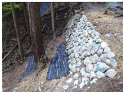
同上：石垣積み替え後の前面の 植生土嚢 (ヤシ繊維ネット内部)
