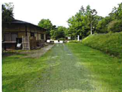
踏圧防止用の芝生保護マットの敷設 （史跡湯築城跡）
