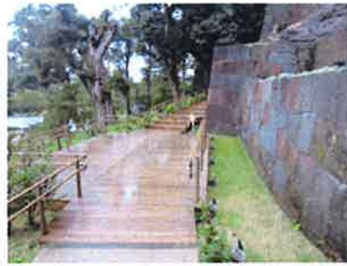
見学デッキ（史跡金沢城跡）
