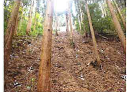
ノンフレーム工法による斜面補強 (史跡津和野城跡 平成 28 年)
