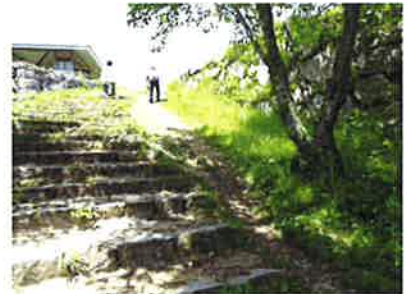
石段際の土壌の流出 ・石段際を歩く来訪者が多いことから、土壌が流出し、雨水排水の水みちとなり、遺構面の損傷につながる。
