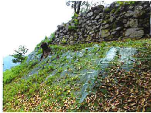
同左：植生シートによる基盤の保護 + 落石防止ネット
