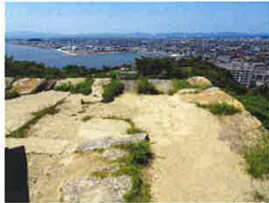
土系硬化舗装の破損部 ・破損部の土壌が固結しすべりやすくなっている。
