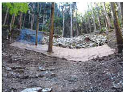
同左：ヤシ繊維ネットと植生土嚢 (ヤシ繊維ネットの内側) による 斜面保護(平成 27 年度)
