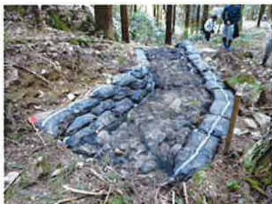
雨水排水の流速低下と分散を目的とした袋型フトンカゴ 平成 27 年度 (史跡津和野城跡：平成 25 年の豪雨災害復旧工事)
