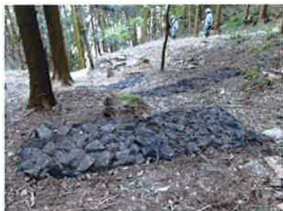
雨水排水の流速低下と分散を目的とした袋型フトンカゴ 平成 27 年度 (史跡津和野城跡：平成 25 年の豪雨災害復旧工事)
