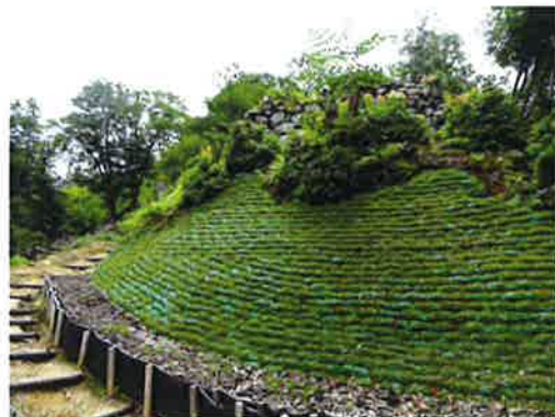
同左：植生土嚢とネット状フトンカゴによる基盤の保護
