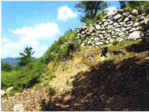
石垣裾の基盤の流出 (史跡有子山城跡)
