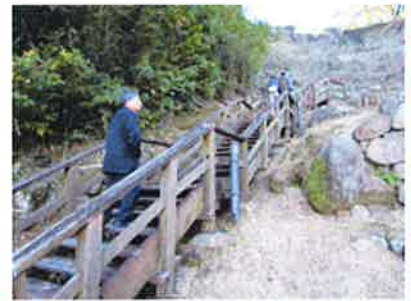
木製階段（史跡新宮城跡）
