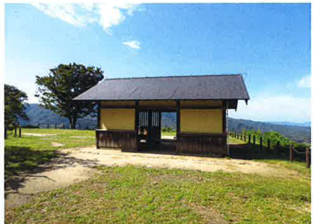
本丸東屋整備事例（月山富田城跡・島根県）
