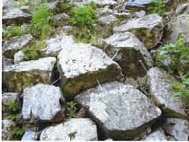
築石と築石にガラス棒を設置 (市史跡出石城跡)
