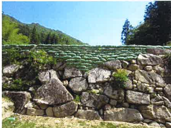
植生土嚢の充填（史跡竹田城跡）
