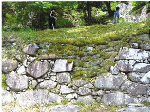
植生土嚢の充填（特別史跡安土城跡）
