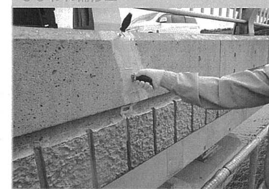
ひびわれ部からの塩分侵入を防ぐひびわれ補修工
