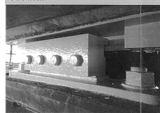
支承鋼製部分の腐食を抑制する支承防錆工
