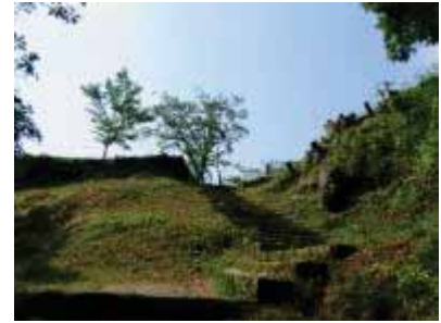
樹木伐採箇所
