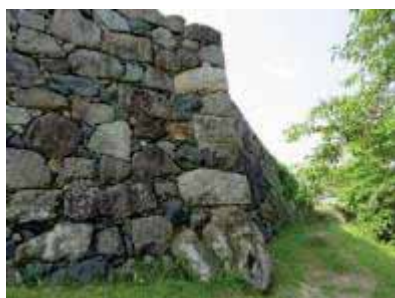
石垣修理箇所
