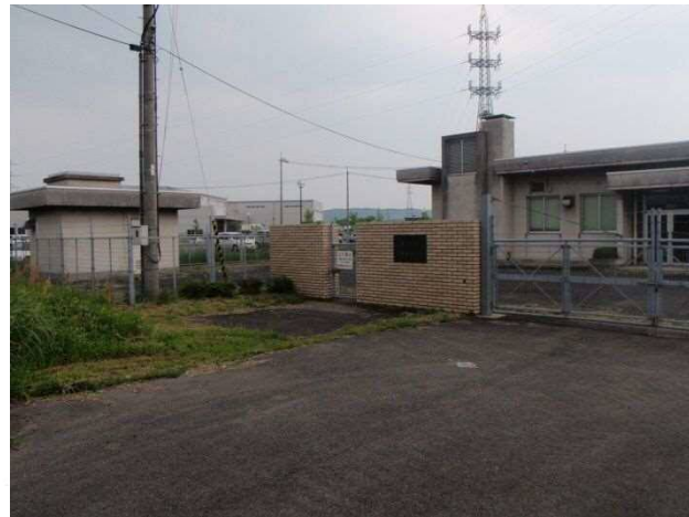
第1号取水井の外観
