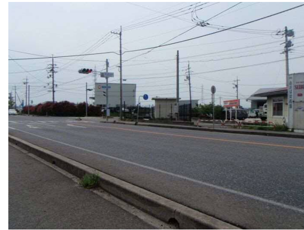
二本木水源地 第2号取水井の外観
