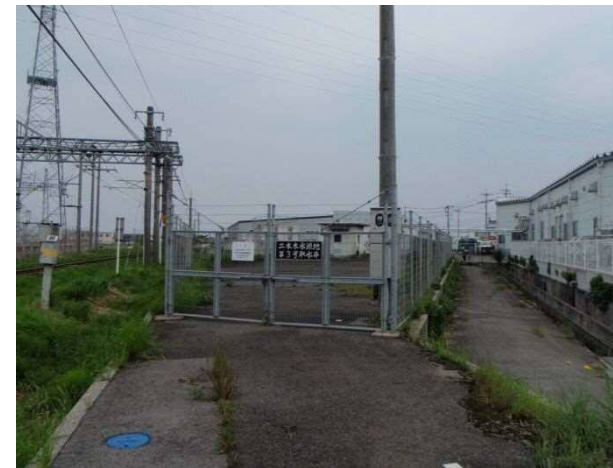
二本木水源地 第 3 号取水井の外観
