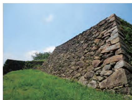
天守石垣（打込接・乱積）
