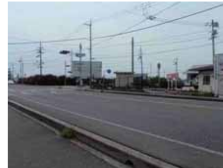
二本木水源地 第2号取水井の外観
