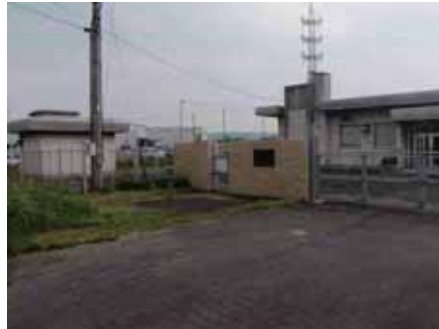
第1号取水井の外観
