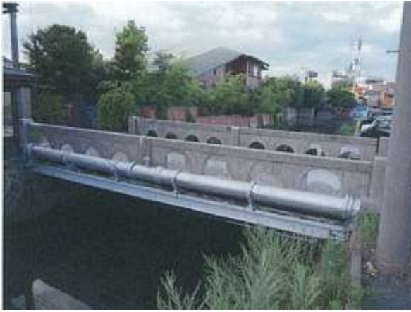
加茂川橋（西倉吉町～尾高町）の水管橋
