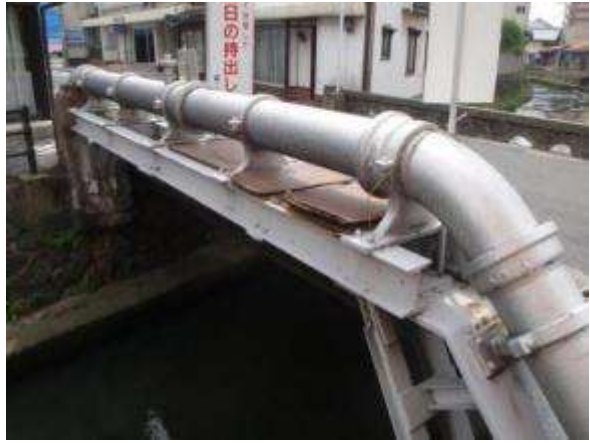
糺町の水管橋
