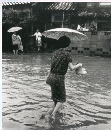
水没する加茂川沿いの道路(紺屋町)
