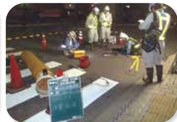
マンホール点検・調査の様子
