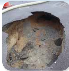
下水道管の破損により道路が陥没した例
