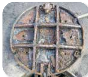
マンホールふたも点検しています
