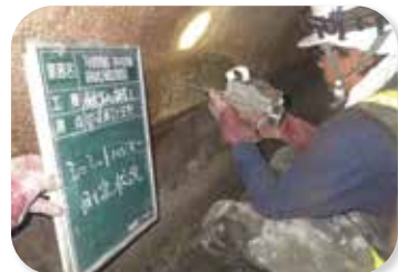
マンホール内部の点検の様子
