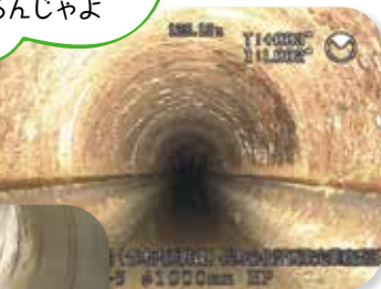
▲管内カメラで撮影した下水道管内部の様子
