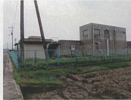
日吉津水源地の外観
